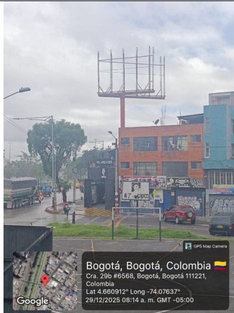
Fotografía No. 2 – Vista de la estructura de la valla previamente instalada.
